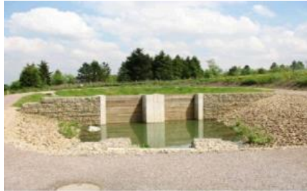
Voirie et Réseaux Divers
